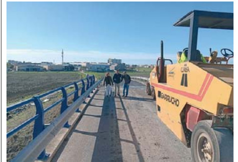
La delegada Susana Sánchez en una visita a las obras del puente. VIVA
